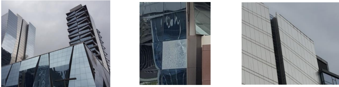
Şekil 4. Next Level Avm ve cephe bozulmaları
