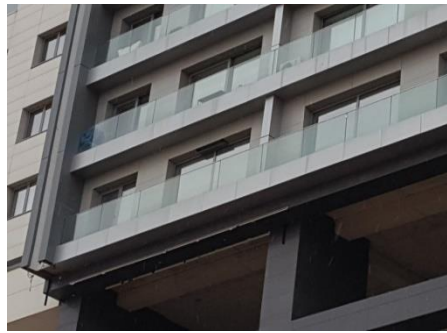
řekil 10. West Gate Rezidans ve panel bozulmaları
